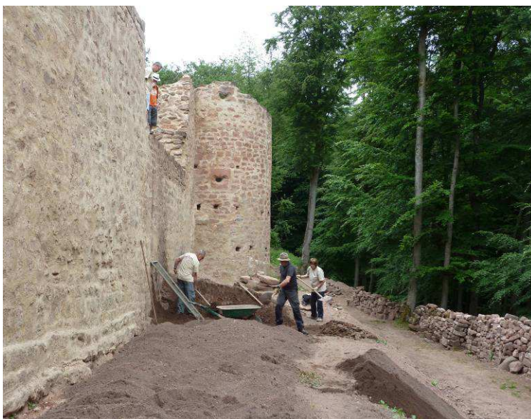
Tamisage et étalement de la terre provenant du puits.
