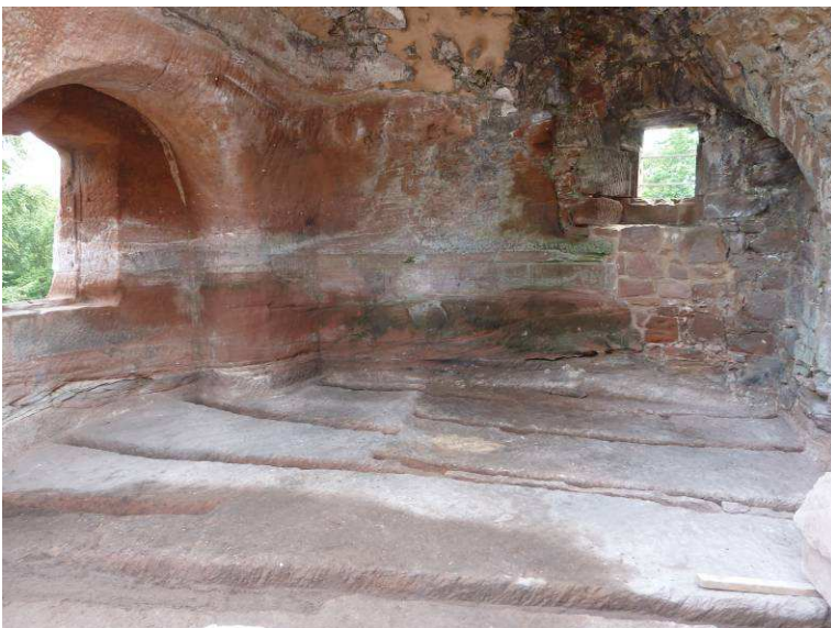
Salle voûtée dégagée.
