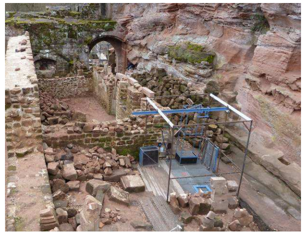
Ossature de l'abri du puits sans la couverture et le bardage.
