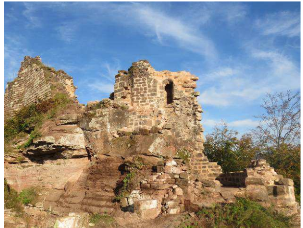
Façade du logis Nord en grande partie jointoyée.
