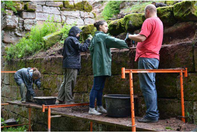
Nettoyage du rempart Ouest en secteur 2.
