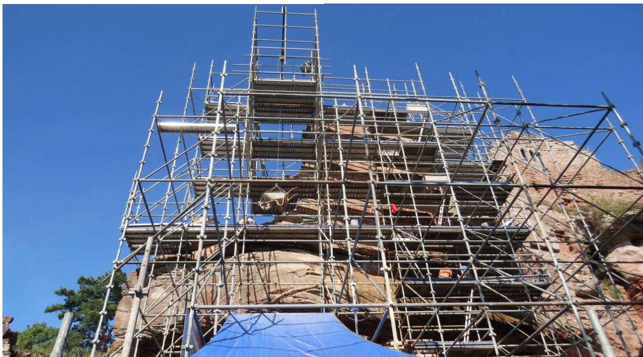
Levage d'une brouette remplie de mortier.
