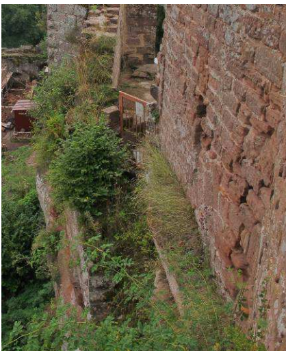
Escalier avant travaux.
