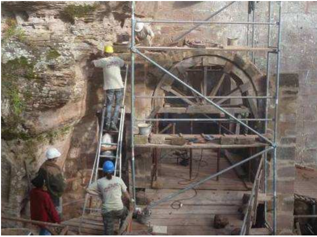
Avant-porte en cours de maçonnerie.
