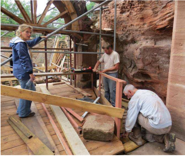
Elargissement de la passerelle.
