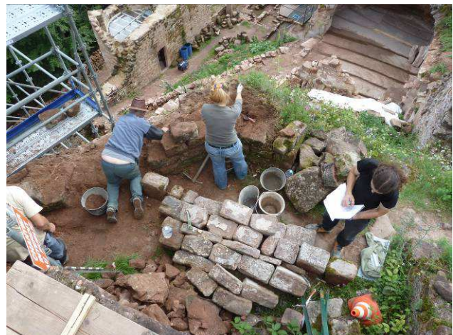
Stockage et relevé des pierres du mur déposées
