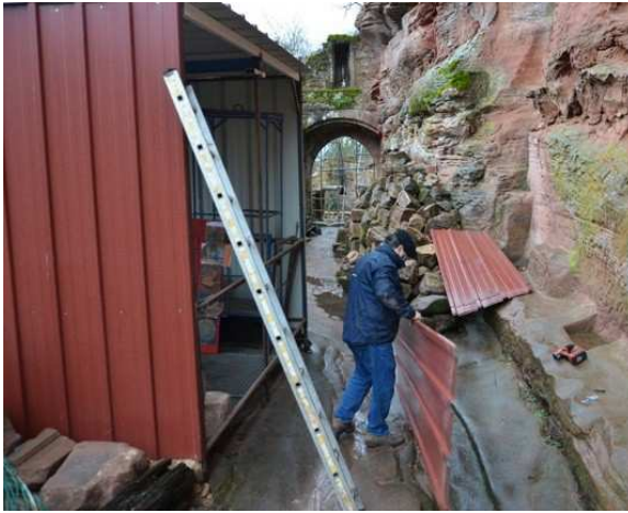
Démontage de la façade de l'abri.
