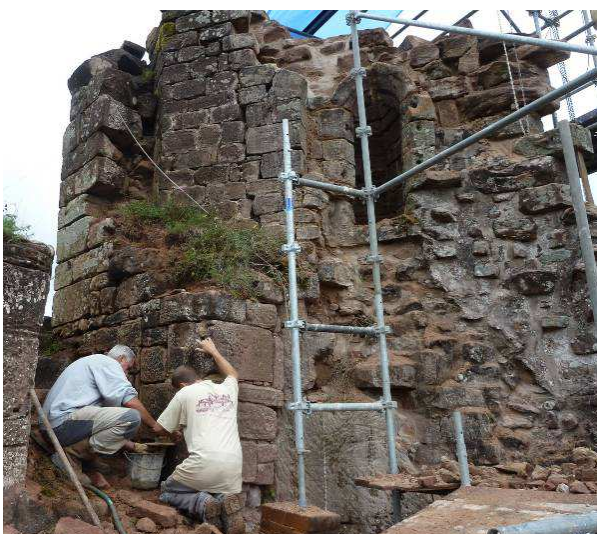
Nettoyage du mur.
