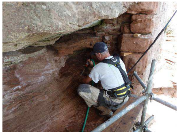
Nettoyage à l'eau sous pression.
