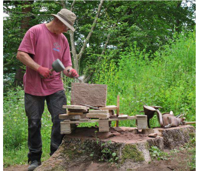
Taille d'un nouveau voussoir pour l'arc de l'avant-porte.
