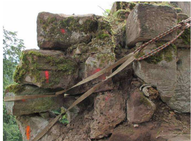
Identification des blocs avant dépose.
