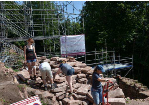
Déplacement des pierres qui se trouvaient sous la voûte.
