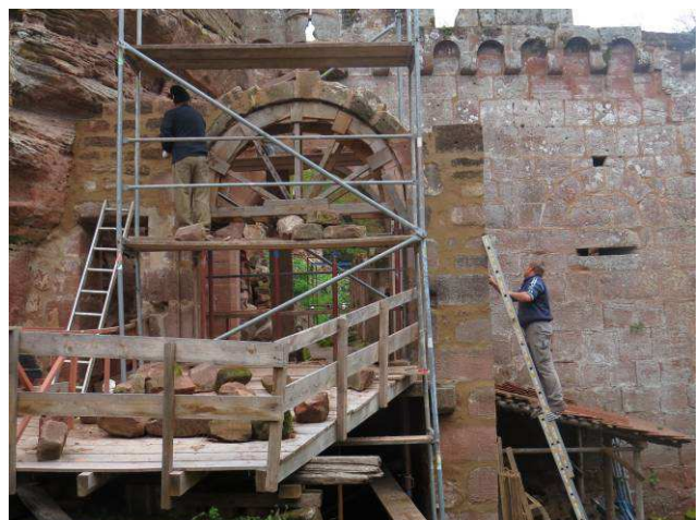
Derniers jointoiements avant l'hiver.
