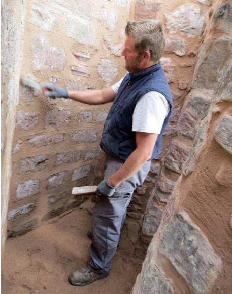
Jointoiment de l'intérieur de la petite pièce.
