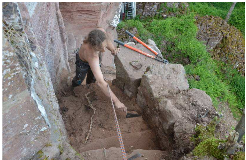
Nettoyage de l'escalier.
