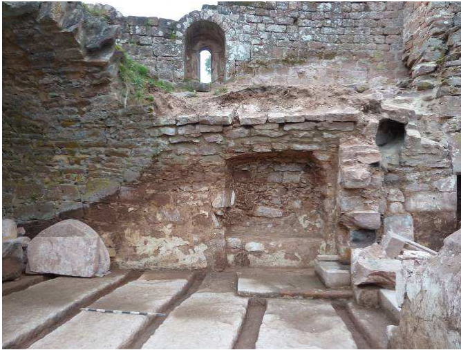
Côté Ouest de la salle avec départ de voûte.
