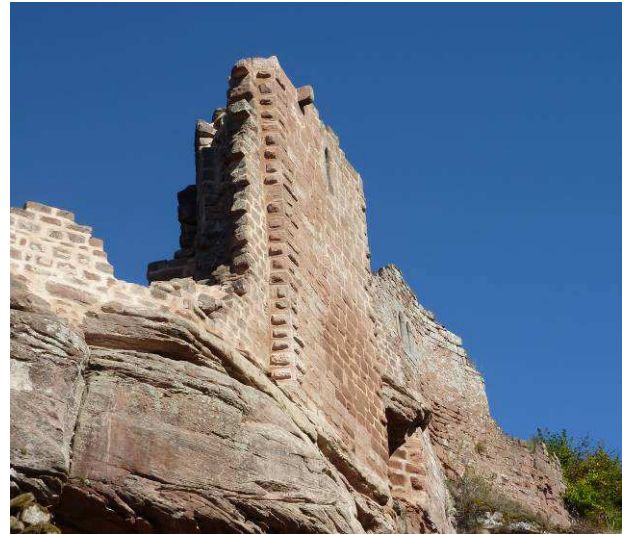
Logis Nord après restauration.
