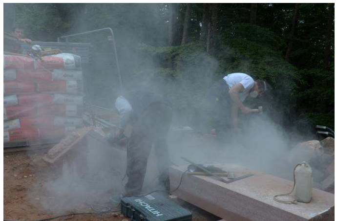
Découpe des pierres à la disqueuse.
