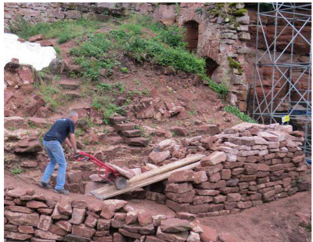
Déplacement des pierres qui étaient situées sous la voûte.
