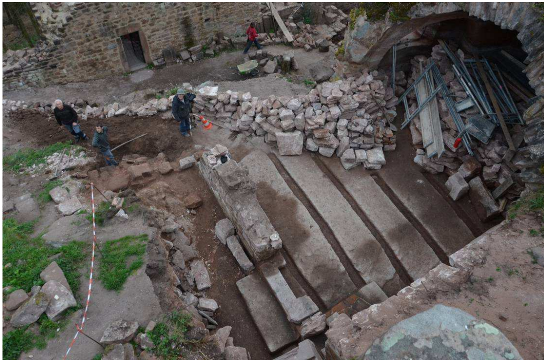
Vue de dessus sur les rainures, le mur et sa porte.
