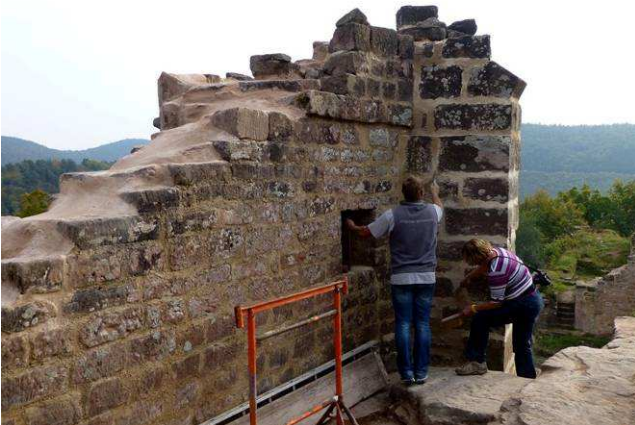
Jointoiment du logis Nord côté intérieur.
