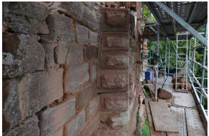
Premières assises du chaînage d'angle remontées.
