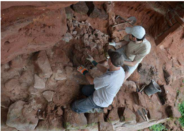
Nettoyage du dessus du mur en contre-bas du logis Nord.
