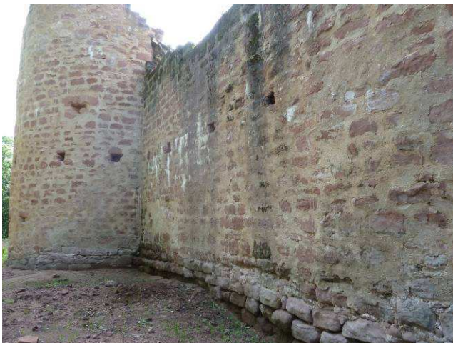
Base du rempart avant jointoiment.
