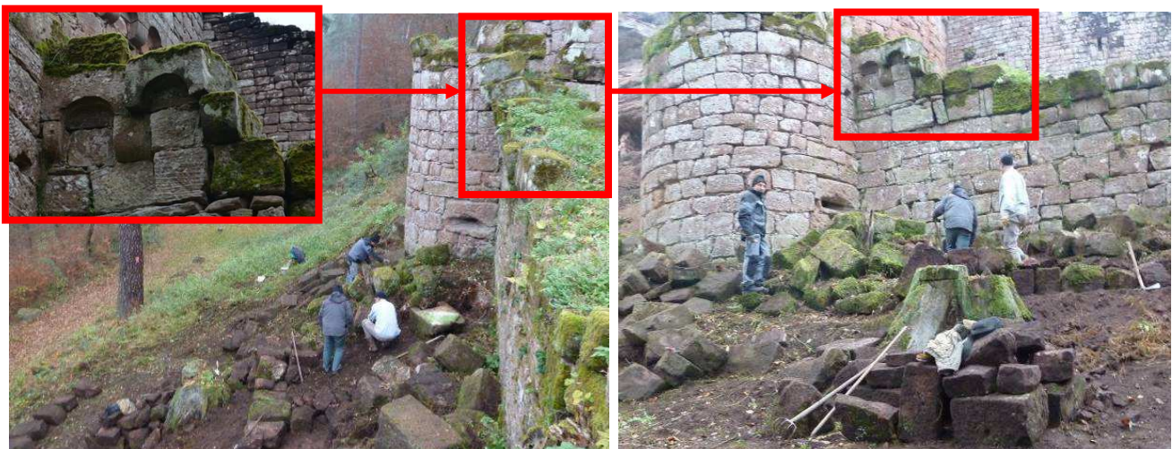
La partie du rempart à redresser est entourée d'un rectangle rouge.
