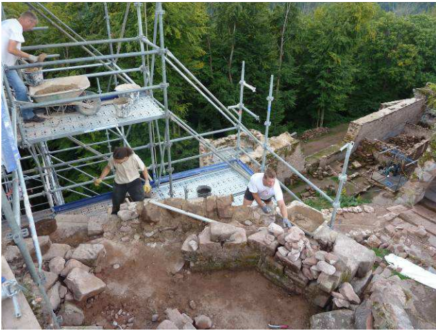
Début du remontage du parement extérieur.
