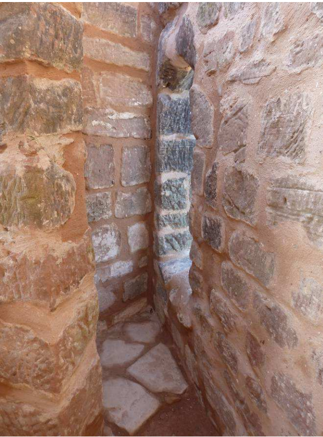
Intérieur du réduit une fois les travaux achevés avec la porte à droite.
