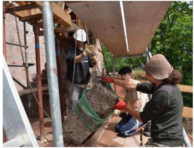
Remontage d'un voussoir de la porte.
