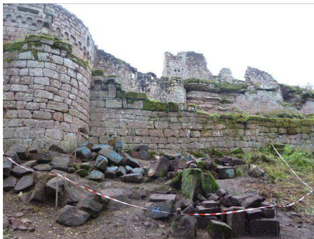
Zone du chantier avec les blocs repérés et brossés.
