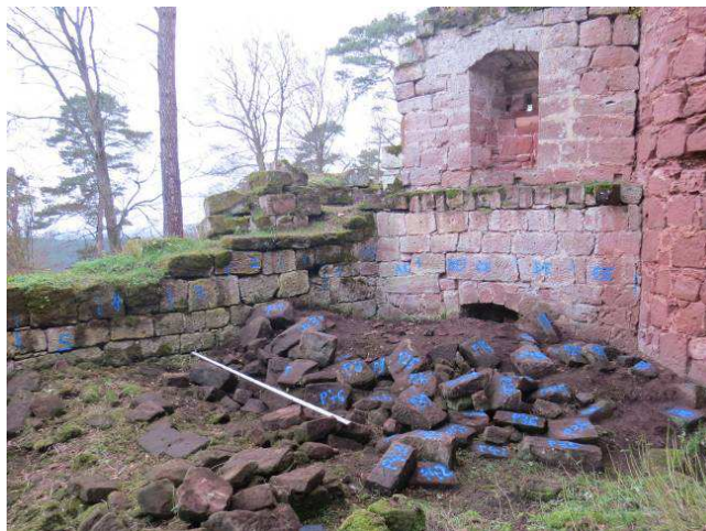
Pierres brossées et repérées, côté basse cour.
