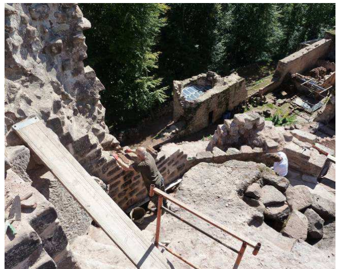
Jointoiement du mur côté intérieur.
