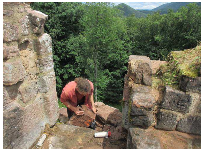
Dépose des pierres.
