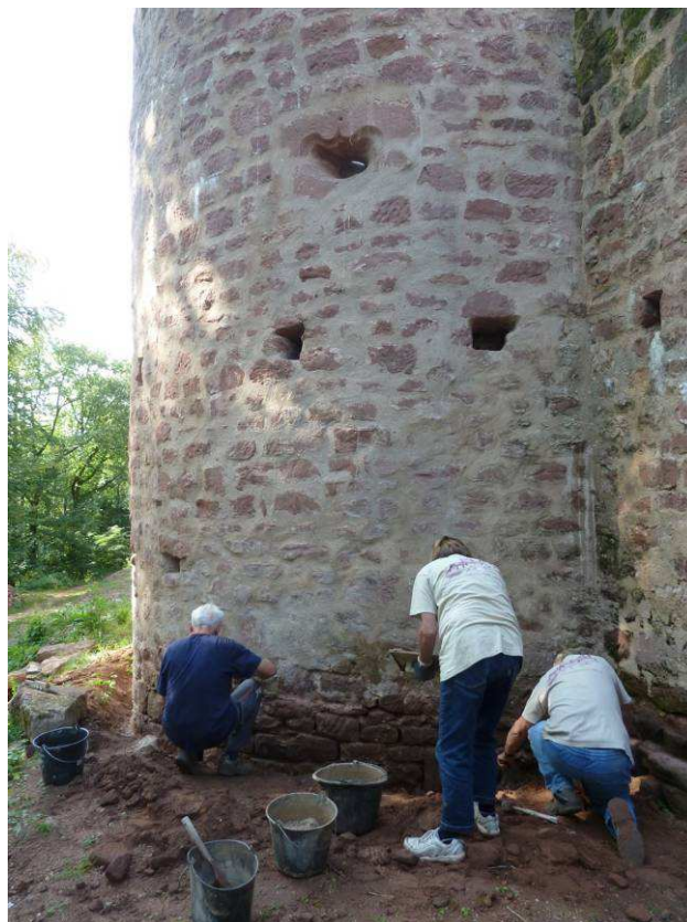
Base de la tour semi-circulaire en cours de jointoiment.
