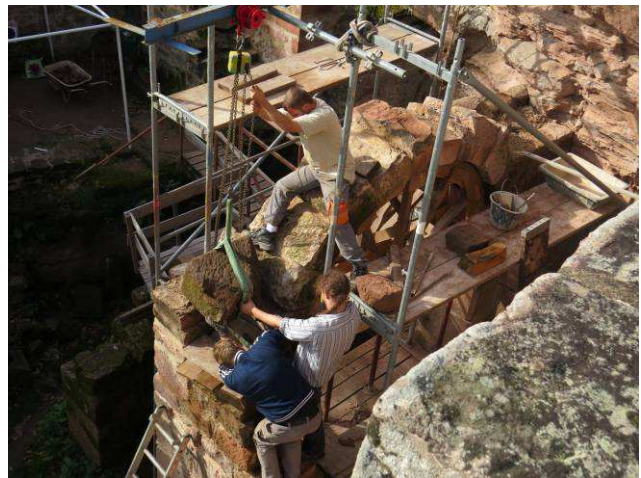
Positionnement d'une pierre du montant droit de l'avant-porte.
