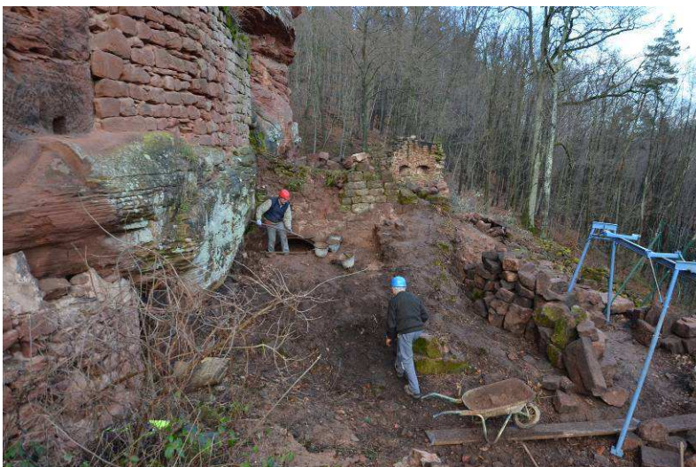
Dégagement de la terre à la hauteur d'une porte au \frac{3}{4} ensevelie.
