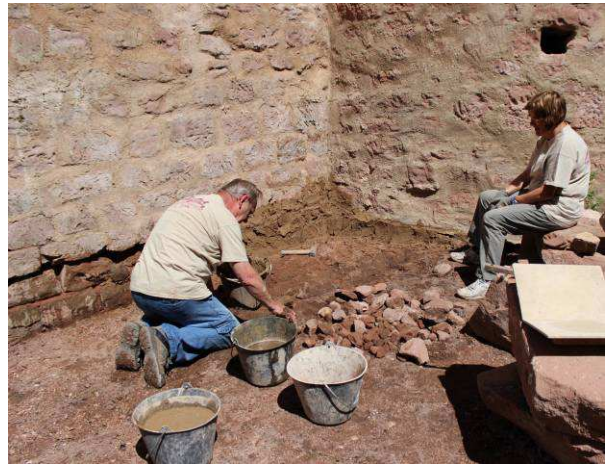
Jointoiment de la base du rempart.
