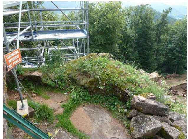
Etat du mur avant dépose, côté intérieur.
