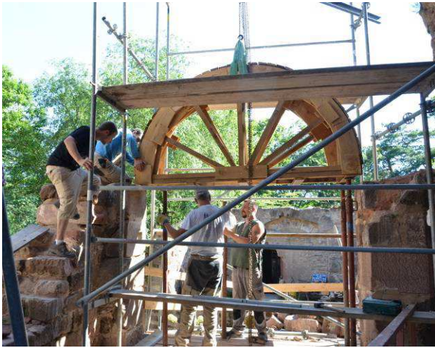
Positionnement du coffrage en bois.
