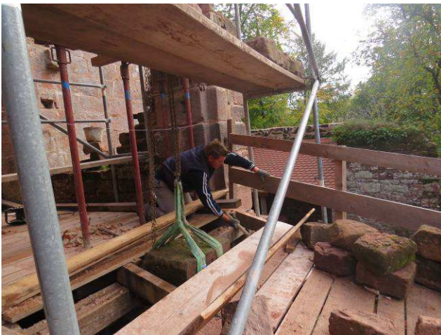
Levage d'une pierre du montant droit de l'avant-porte.
