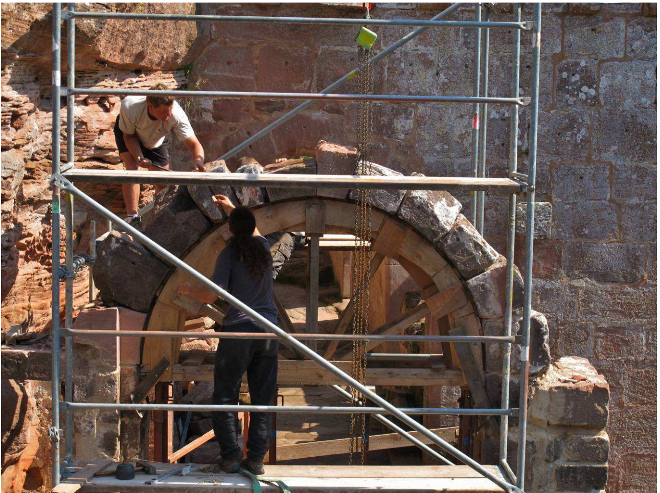
L'ensemble des voussoirs de l'arc ont été posé.
