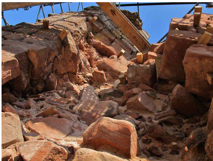
Purge du mur et stabilisation des moellons avec des cales en bois.
