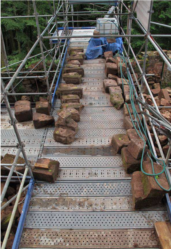
Pierres d'origines du chaînage d'angle.
