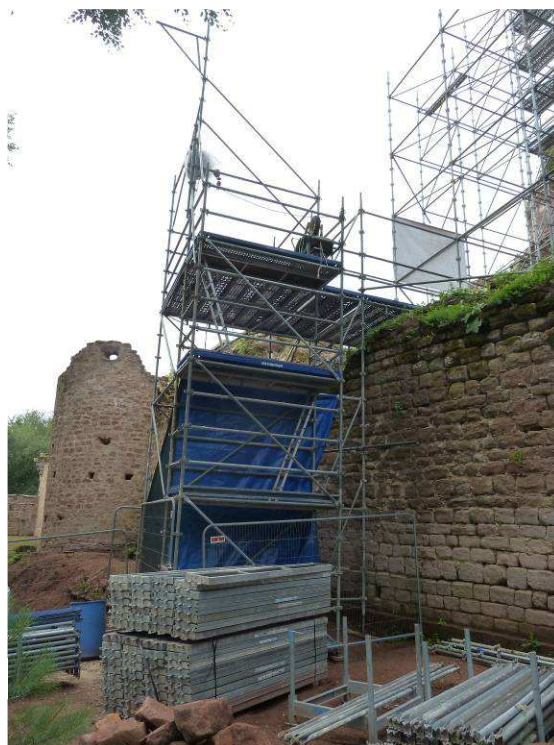
Tour d'accès au chantier.
