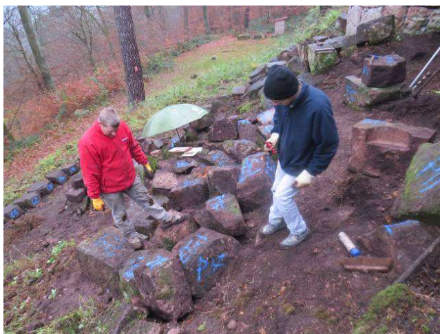
Repérage des blocs du rempart, côté extérieur du château.
