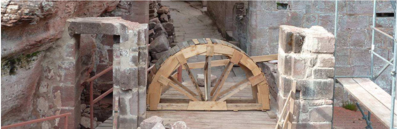
Cintre de l'arc de l'avant-porte.
