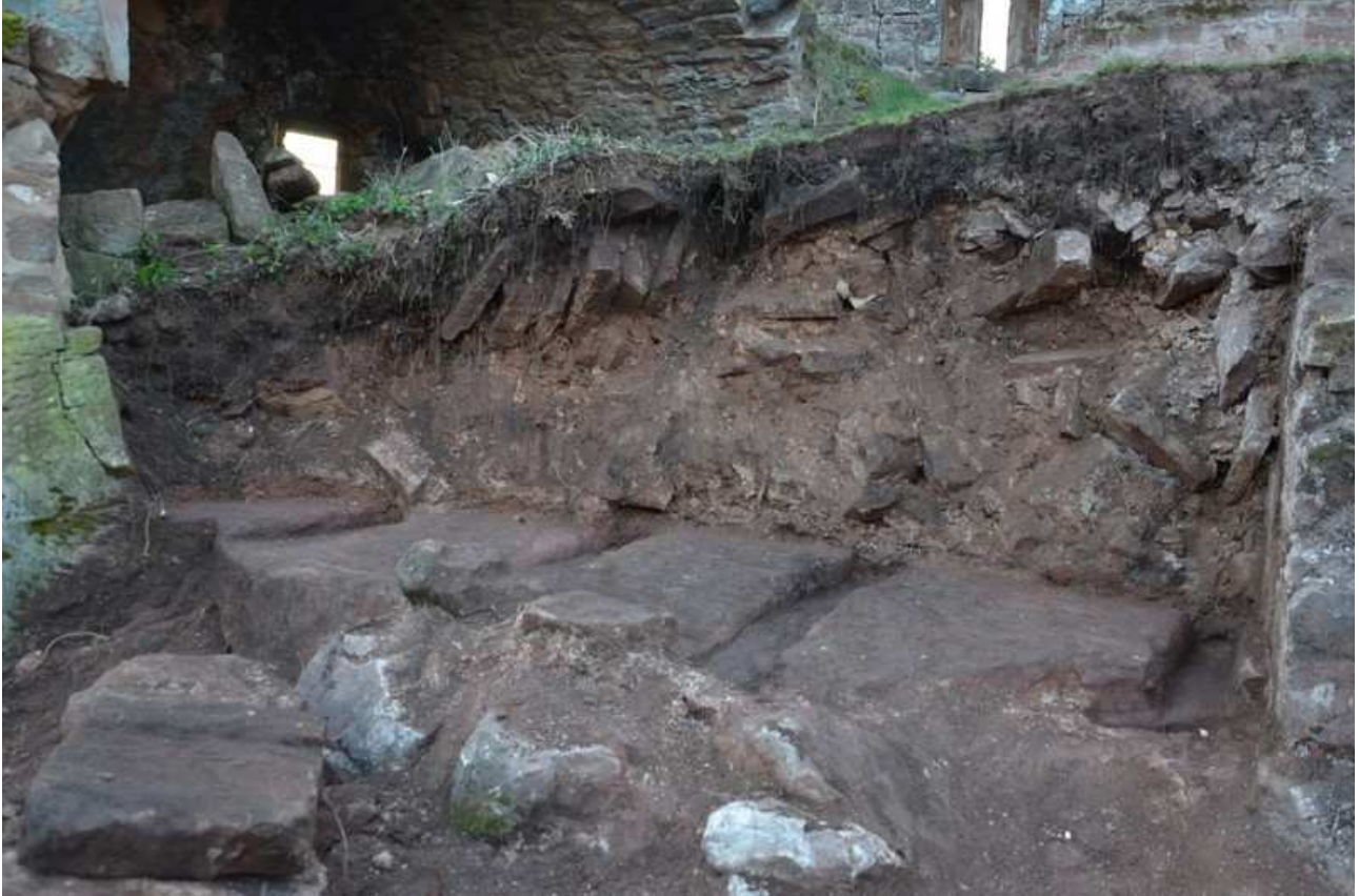
Coupe du terrain à l'extrémité Est de la salle voûtée. Les rainures taillées dans le rocher et les pierres de la voûte apparaissent.
