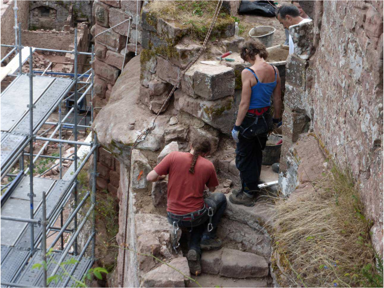
Consolidation du mur au départ de l'escalier.
