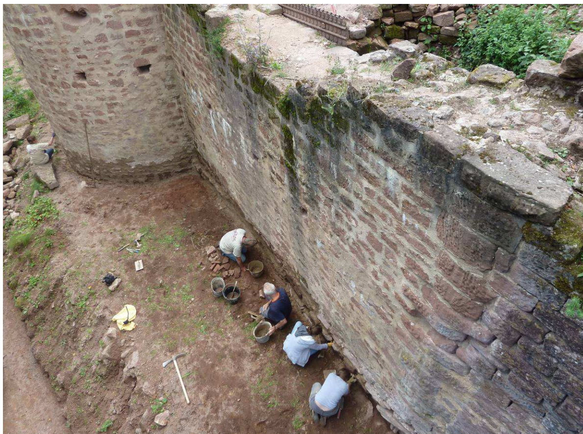
Base de la tour semi-circulaire en cours de jointoiment.
