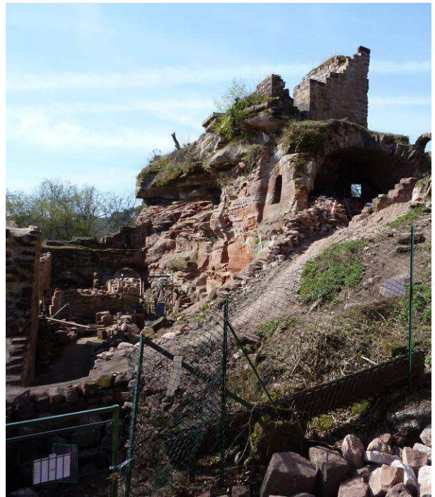
Rampe d'accès au chantier.
