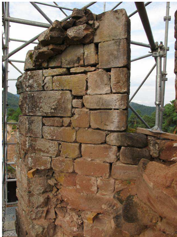
Vue sur la porte du petit local, côté intérieur, avant consolidation.
