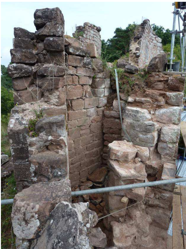
Petit local avant consolidation.
