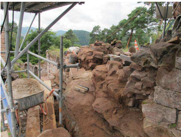
Mur dépose jusqu'au rocher.
