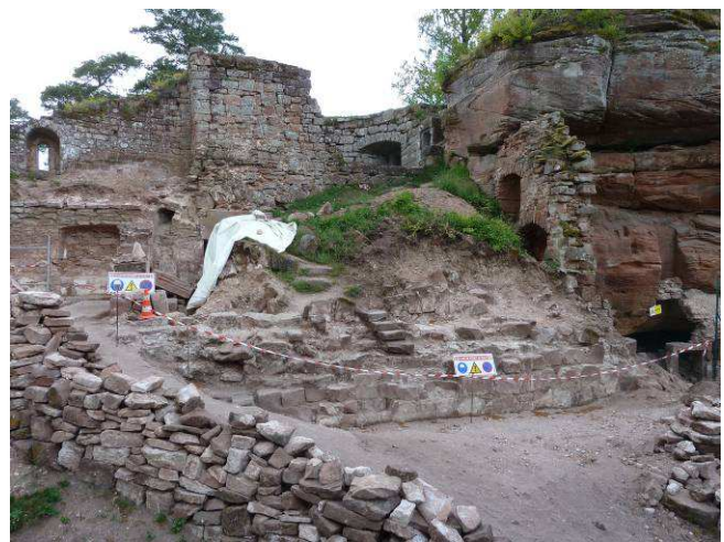
Partie de la façade Est du bâtiment dégagée.
