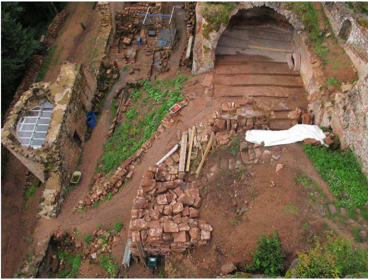
Vue sur le stockage des pierres, la rampe et la salle voûtée dégagée.
