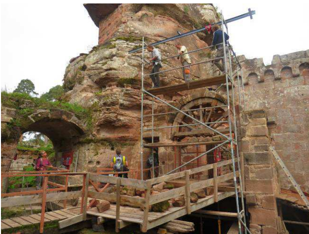
Vue d'ensemble de l'avant-porte.
