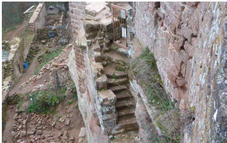
Escalier à la fin des travaux de 2014.
