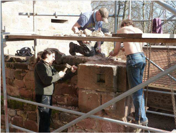
Dépose des pierres.
