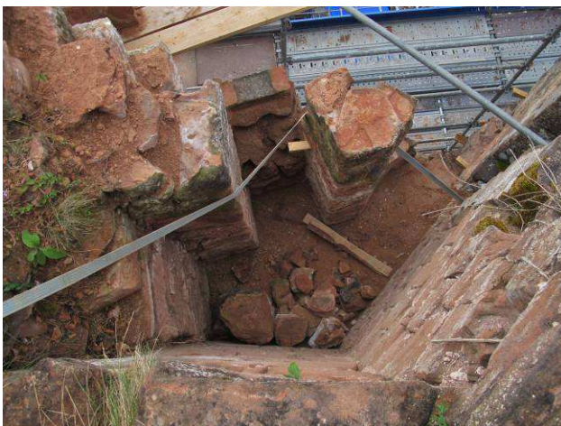
Vue de dessus du petit local avec l'entrée à droite.
