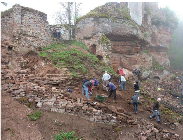
Dégagement de l'imposant mur de la façade Est.
