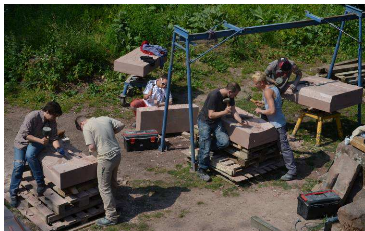
Equipe du CFA en train de tailler la margelle.
