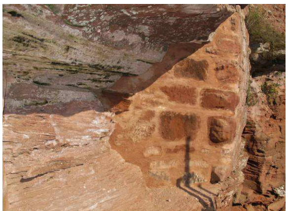
Mur consolidé et jointoyé.
