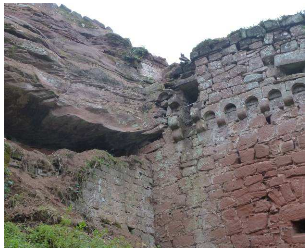
On aperçoit le mur déposé au-dessus des latrines du gros bastion.
