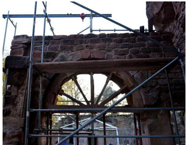
Arrière de l'avant-porte à la fin des travaux de 2014.
