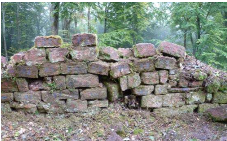
Etat du parement intérieur du rempart est en octobre 2013 puis en 2016 avant sa consolidation.
