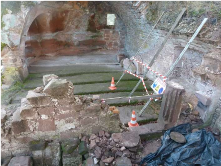
Le montant ouest repositionné à son emplacement d'origine.
