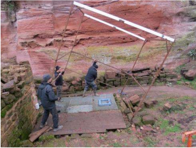
Démontage de la structure de l'abri du puits
