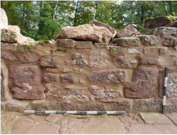
Entrée des latrines bouchées et un morceau de sa pierre percée.
