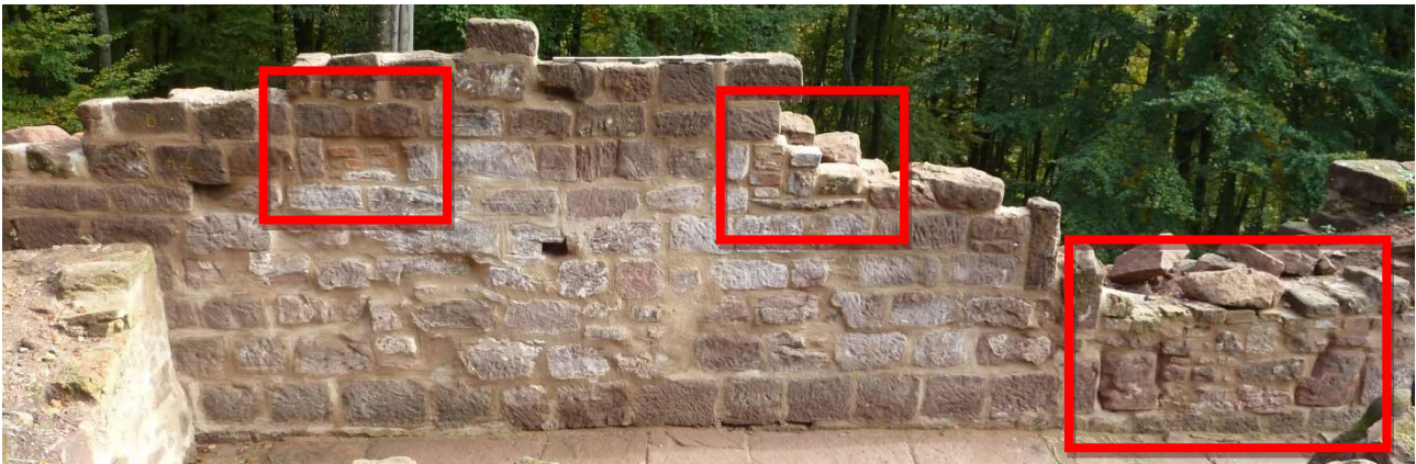
Entrée des latrines bouchées et un morceau de sa pierre percée.
