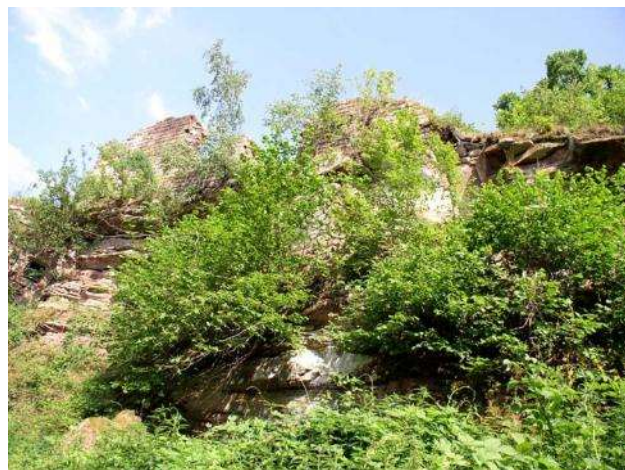
Photo prise du côté ouest du rocher, sans doute avant 2001.
