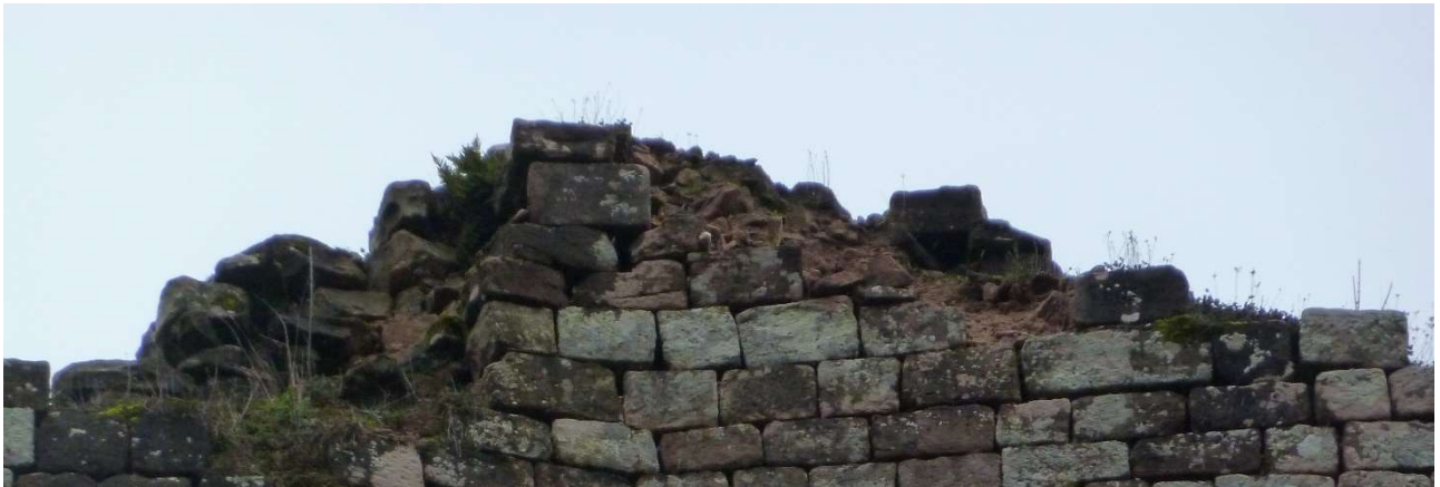
Avant et après chute des blocs de parement du mur ouest.
