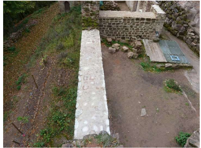
Les deux dessus de murs maintenant protégés.
