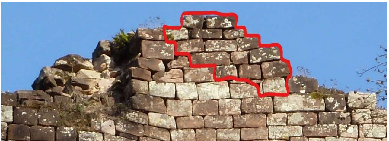
Avant et après chute des blocs de parement du mur ouest.
