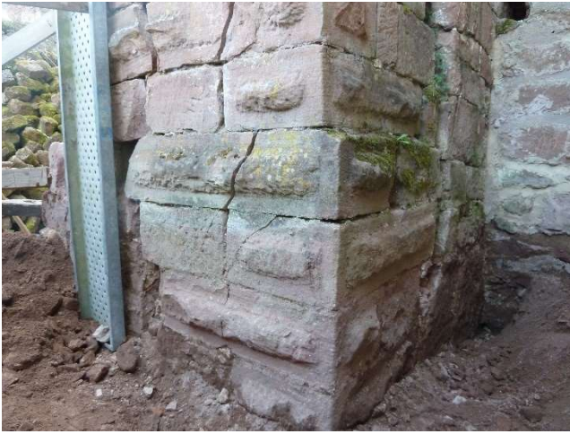
Ci-dessus, le mur d'angle à pierre à bosse en très mauvais état qui faudra déposer puis remonter à l'intérieur de la tour octogonale.
