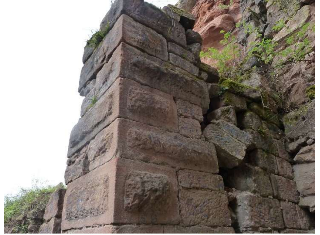
Ci-dessus, le mur d'angle à pierre à bosse en très mauvais état qui faudra déposer puis remonter à l'intérieur de la tour octogonale.
