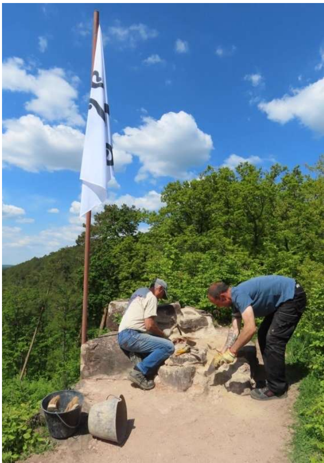
Ci-dessus, le parement intérieur écroulé sera restauré et ses pierres retrouveront leur emplacement d'origine en 2023.
