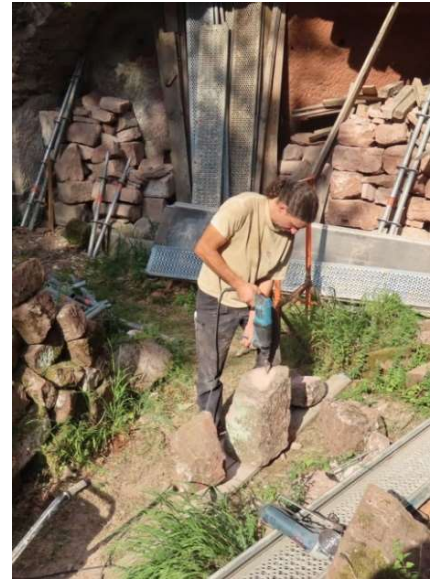
Ci-dessus, recherche du bon bloc pour la canonnière, mesures pour le retailler puis perçage pour mettre les tiges en inox.
