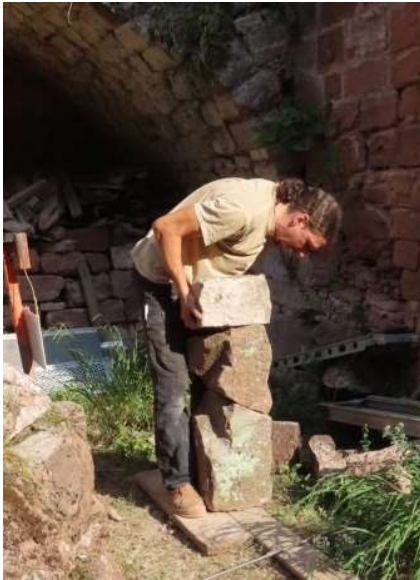
Ci-dessus, recherche du bon bloc pour la canonnière, mesures pour le retailler puis perçage pour mettre les tiges en inox.
