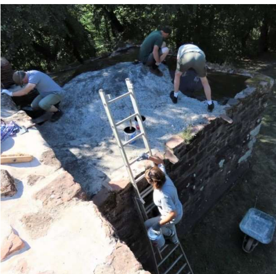
Il aura fallu 9 seaux de 5 kg du produit hydrofuge.
