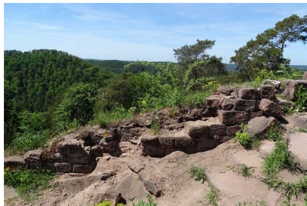
Ci-dessus, le parement intérieur écroulé sera restauré et ses pierres retrouveront leur emplacement d'origine en 2023.
