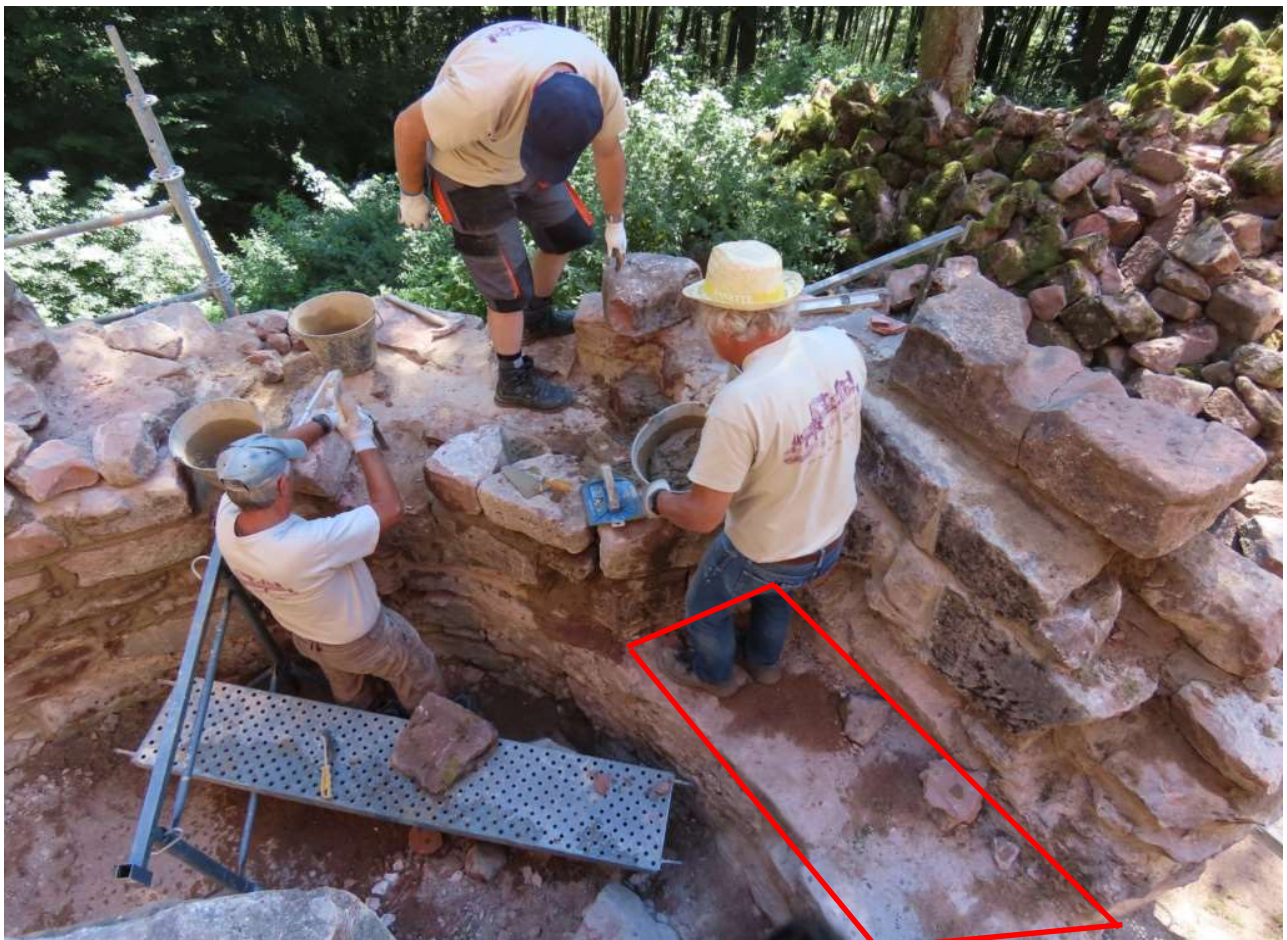
Ci-dessus, maçonnerie du mur à côté de la bouche à feu. La zone rouge délimite son embrasure. Le niveau sol en terre était au niveau de l'embrasure. Par la suite, de la terre sera remise jusqu'à ce niveau d'origine.
