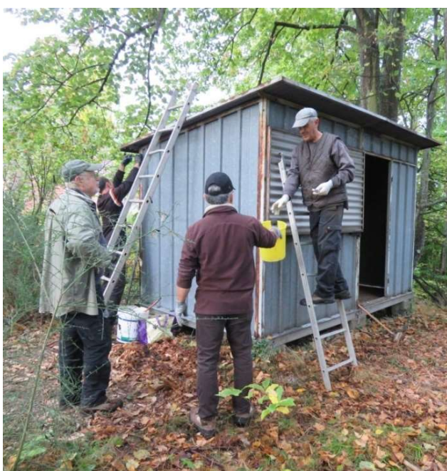
Démontage du cabanon aux châteaux d'Ottrott.
