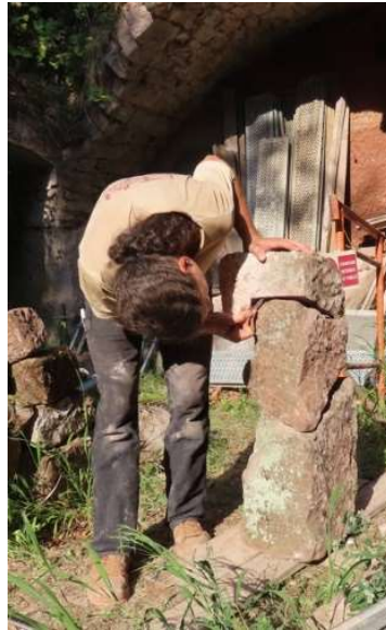
Ci-dessus, recherche du bon bloc pour la canonnière, mesures pour le retailler puis perçage pour mettre les tiges en inox.
