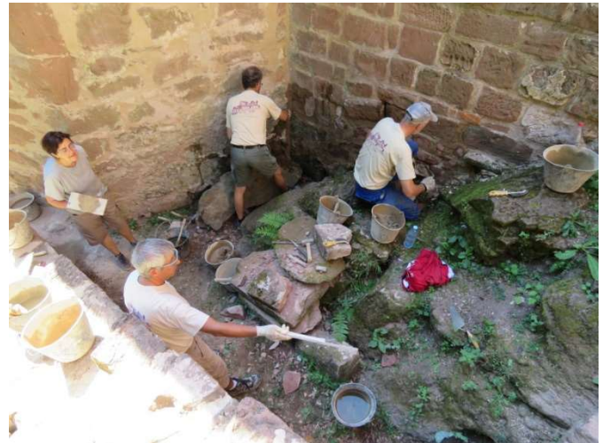
Ci-dessus, quelques pierres ont été taillées pour compléter l'évacuation des anciennes latrines.
