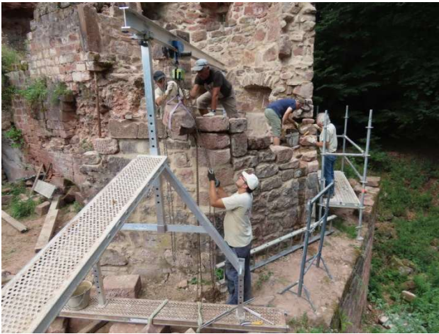
Ci-dessus, recherche du bon bloc pour la canonnière, mesures pour le retailler puis perçage pour mettre les tiges en inox.
