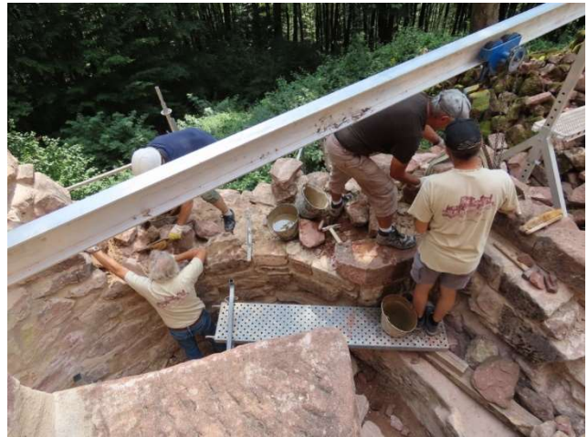
Ci-dessus, recherche du bon bloc pour la canonnière, mesures pour le retailler puis perçage pour mettre les tiges en inox.
