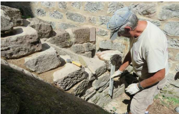
Ci-dessus, quelques pierres ont été taillées pour compléter l'évacuation des anciennes latrines.
