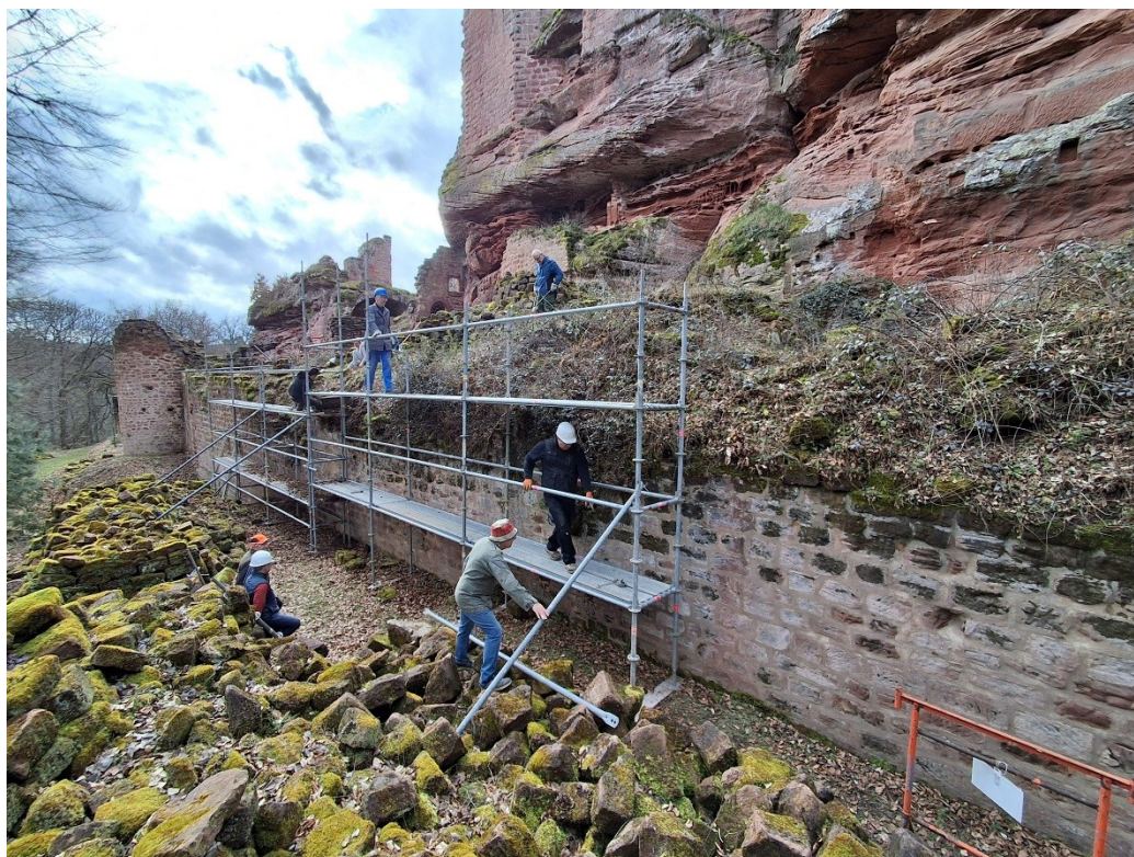
Pose de l'échafaudage le long de la courtine est.
