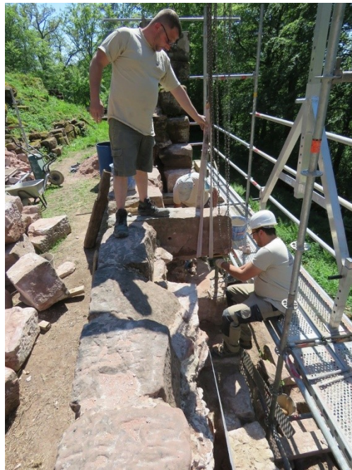
Dépose des deux blocs sous la boutisse...
