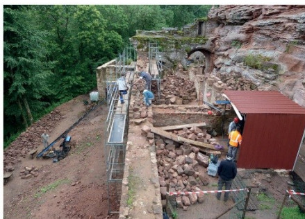
Chantier du bâtiment Renaissance et du puits en 2013
