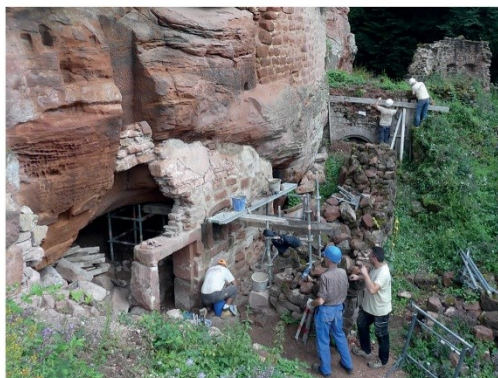
Consolidation de l'abri sous roche et d'un autre mur en 2025
