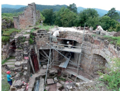
Jointoiement de la voûte en 2023
