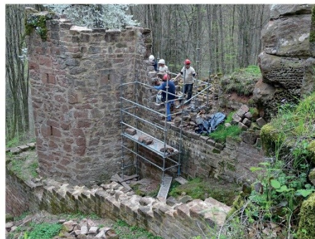
Ci-dessous : La tour, la fausse-braie et le mur bouclier en 2023
