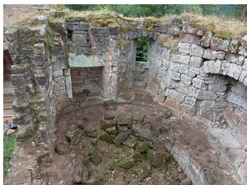
L'intérieur du gros bastion sans la voûte en 2015
