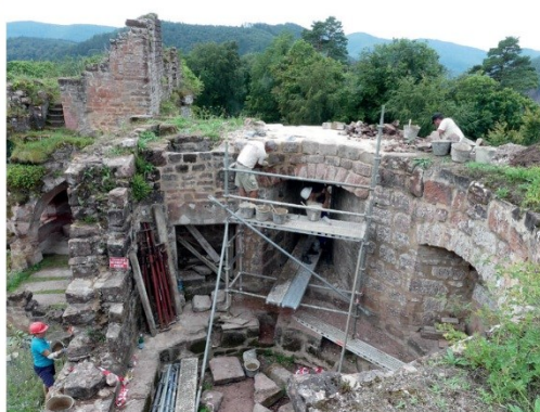
Jointoiement de la voûte en 2023
