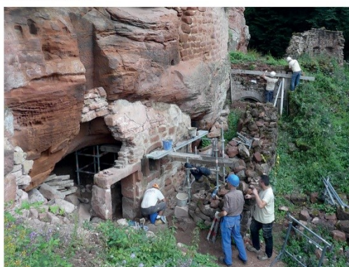
Consolidation de l'abri sous roche et d'un autre mur en 2025
