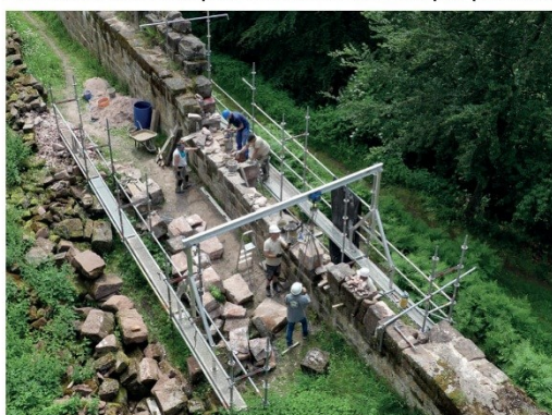
Remontage du parement extérieur de la courtine Ouest en 2024
