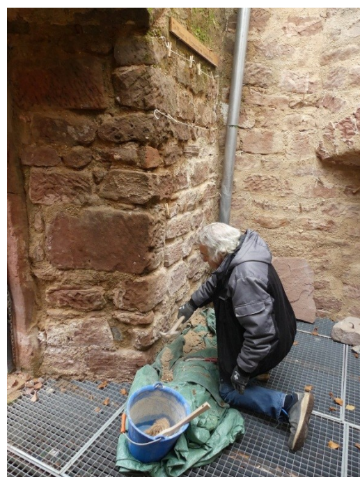
Préparation du mur dans la tour avant d'en refaire les joints en 2026.
