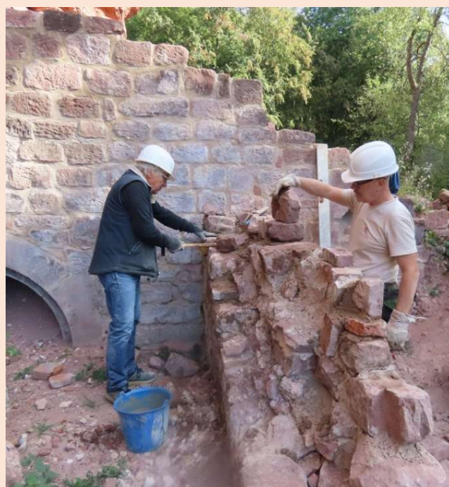
Consolidation de l'arrière de la porte avec l'arc de décharge.
