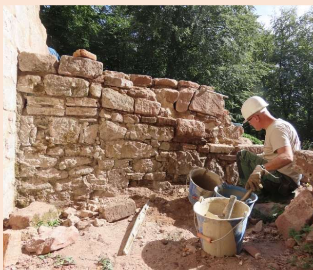
Consolidation de l'arrière de la porte avec l'arc de décharge.
