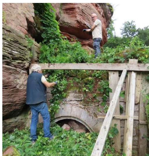
Au nord de l'abri, nous avons dégagé la porte de sa végétation pour consolider le mur qui s'était écroulé il y a quelques années.
