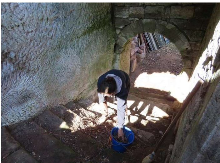
Nettoyage de l'escalier.
