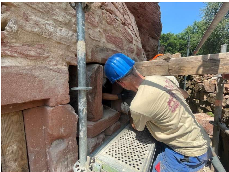
Dépose des montants de la fenêtre.
