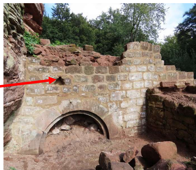
Mur nécessitant un futur renforcement.
